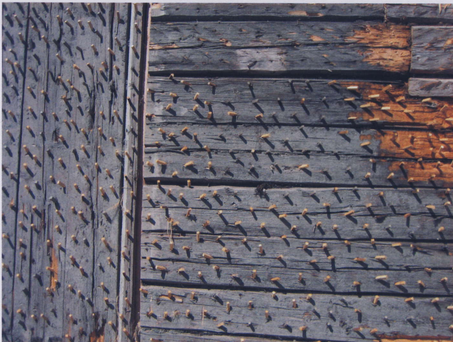
Ulkoseinän rappauksessa puutappien avulla saavutetaan hyvä tartunta ja taataan näin saven pysyminen seinässä. Tappien tulee aina olla tiheästä puusta.
